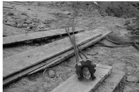
(b) 锚固体与钢绞线连接
