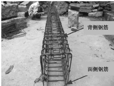
图3 抗滑桩钢筋笼的制作
