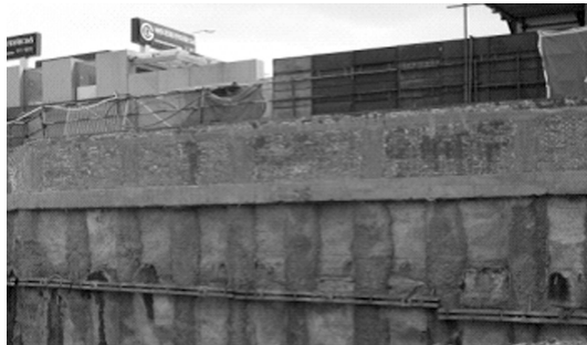
图3 基坑南侧支护情况
