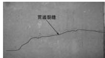
图3 模型顶部贯通裂缝图
