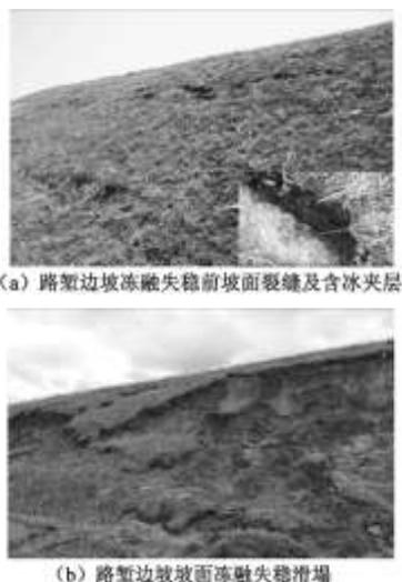
图 1 同三公路 K560+450 段路堑边坡滑塌前后照片
