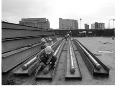
图 4 桩体倾斜管预埋管照片
