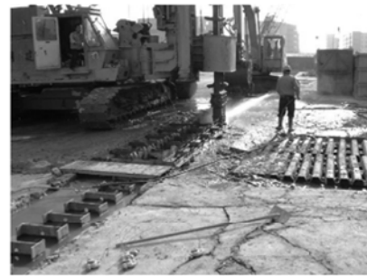
图 3 SMW 施工照片
