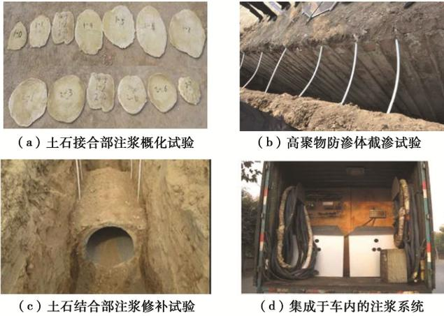
图 26 土石坝结合部渗漏险情的快速截渗及快凝注浆技术
