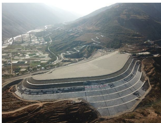
图 1 象鼻岭移民安置点防护堤工程鸟瞰图
