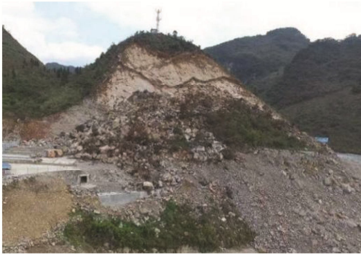
图1 三荔高速顺层岩质阶梯状滑面失稳案例 [8]
