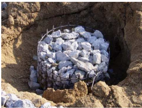
图 1 筋箍碎石桩工程图片
