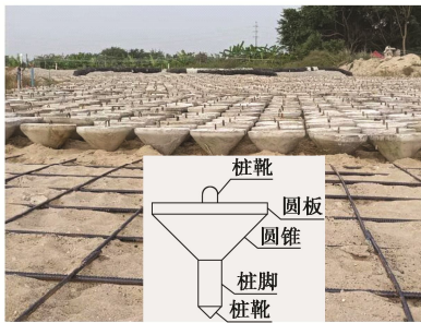
图1 铺设陀螺桩混凝土块
