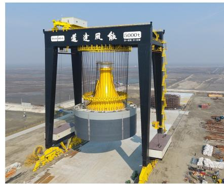
图 2 复合桶型基础现场结构图
