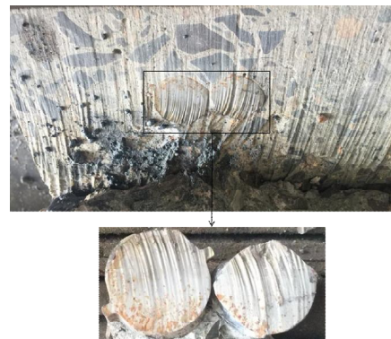
图 11 钢筋混凝土内部切割形状
