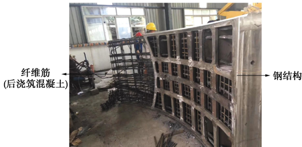
图 4 第 4 环复合管片示意图
