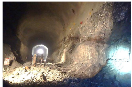
图 13 右岸尾水管检修闸门室下游侧岩壁梁 C_5 挖除后照片
