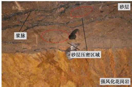
图1 砂层注浆现场照片(青岛地铁2号线啤一苗区间)
