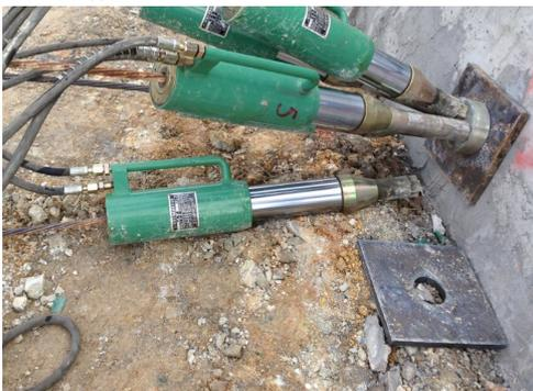
图1 多个千斤顶对各锚筋同步张拉
