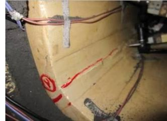
(c) 第3条裂缝（左墙脚）
