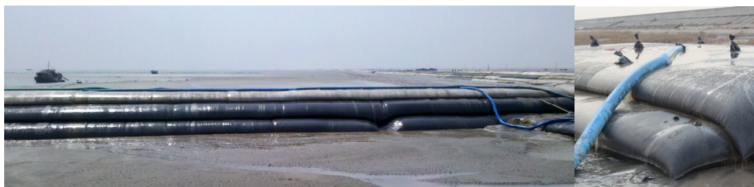
图 2 管袋堤坝充填施工
