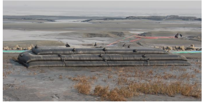
图6 充填及脱水固结后形成的管袋坝体
