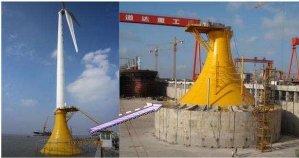
图 1 复合筒型基础样机工程
