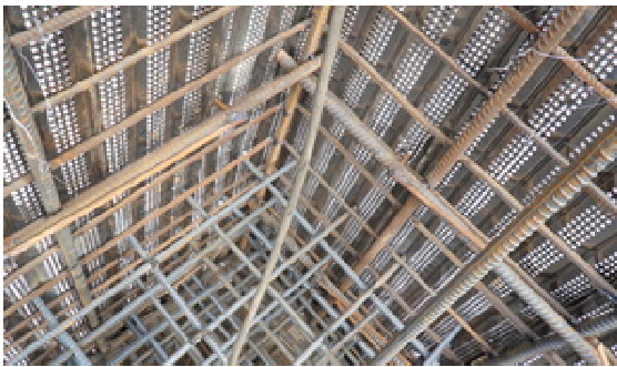
图4 收口网模板及预留孔钢筋布置
