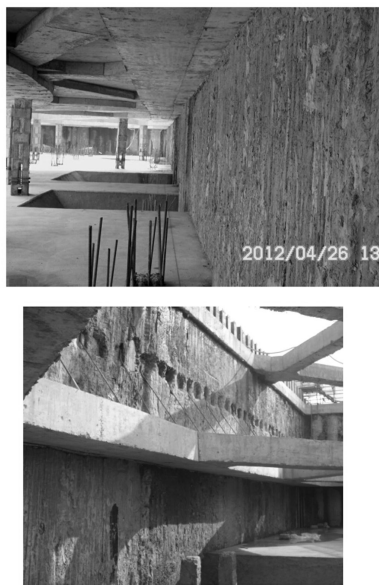
图 14 等厚度型钢水泥土搅拌墙侧壁实景
