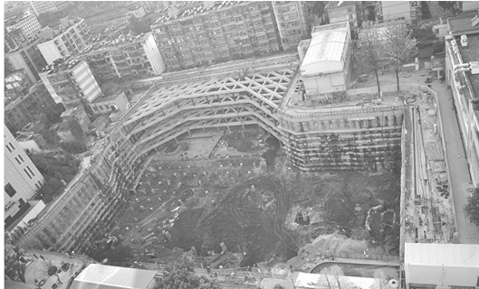
图10 施工完成的桩锚与桩撑组合支护综合楼基坑
