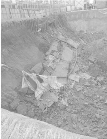
图 6 桩锚基坑滑塌
