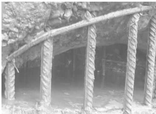
图 3 塌孔导致断桩
