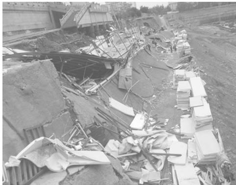
图 2 坑壁土钉墙滑塌
